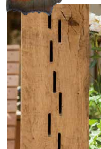
Vlinderkolom - vlindernest-openingen in houten kolom
